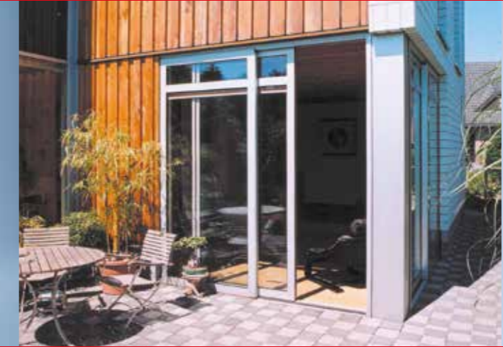
optimaler Wasserablauf durch schräge Schwellen
